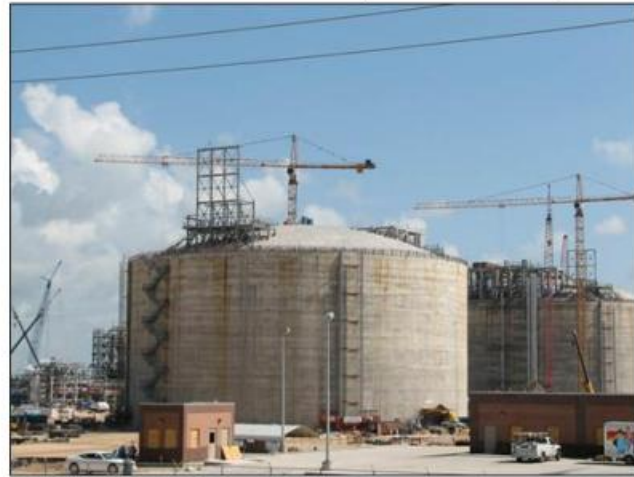
Freeport LNG Construction Site August 2007
