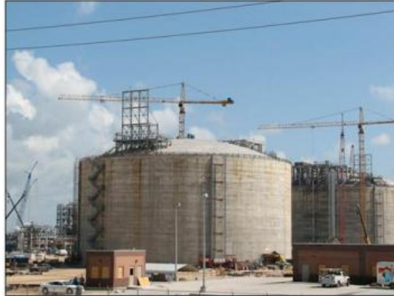
Freeport LNG Construction Site August 2007
