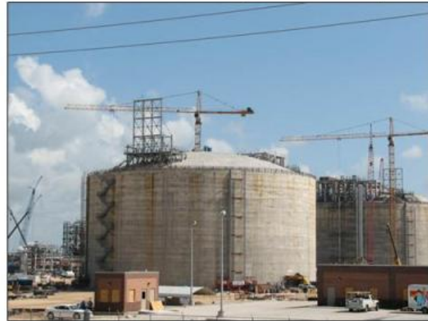
Freeport LNG Construction Site August 2007
