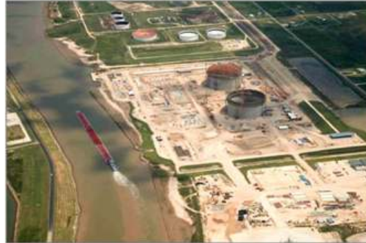
Freeport LNG Construction Site
