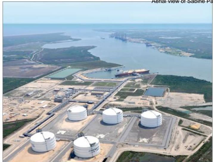
Aerial view of Sabine Pass LNG
